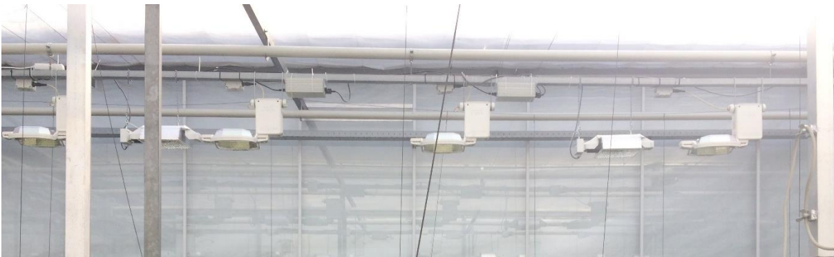
Foto 2. Dim-regime SON-T: naast de 1000W SON-T zijn er acht 250 Watt SON-T lampen bij gehangen. Deze lampen gaven gemiddeld 30 \mu\text{mol}/\text{m}^2/\text{s} PAR en konden via de klimaatcomputer worden bediend.
